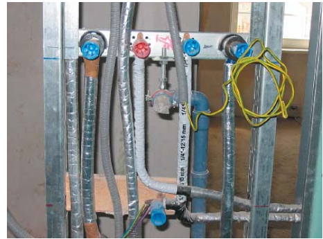
Beispiel: Zwischenwandinstallation im Sanitärbereich mit HERZ- Rohren
