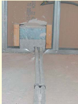
Beispiel: Anschluss HERZ- Unterputzverteiler
