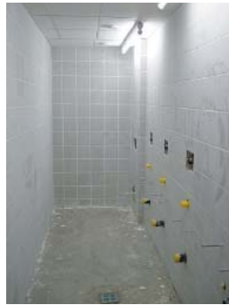
Beispiel: Zwischenwandinstallation im Sanitärbereich mit HERZ- Rohren
