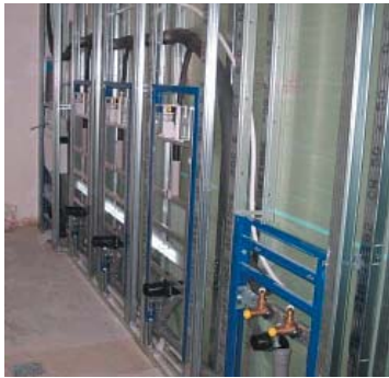
Beispiel: Zwischenwandinstallation im Sanitärbereich mit HERZ- Rohren
